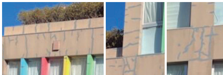
工事が必要な箇所の例
