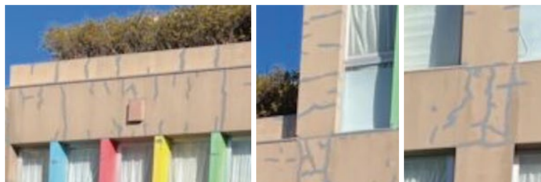
工事が必要な箇所の例
