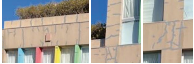
工事が必要な箇所の例
